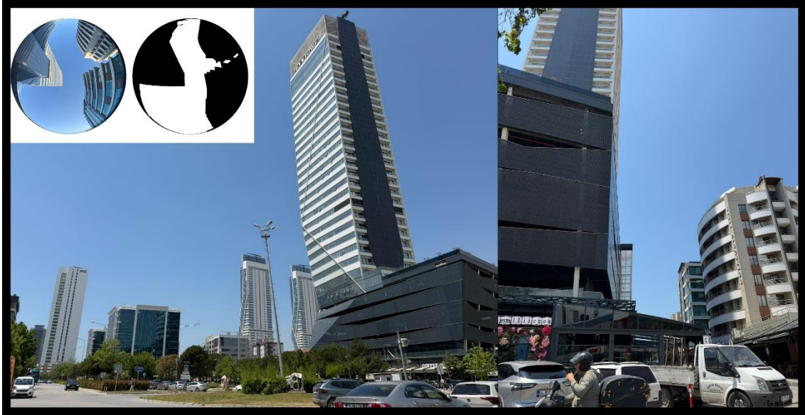
Şekil 13 Yüksek Katlı Dar Sokak Yapılı Alanda Güneş Hakkı Problemi ve Gölgeleme Kaynak: Yazarın Kişisel Arşivi.
