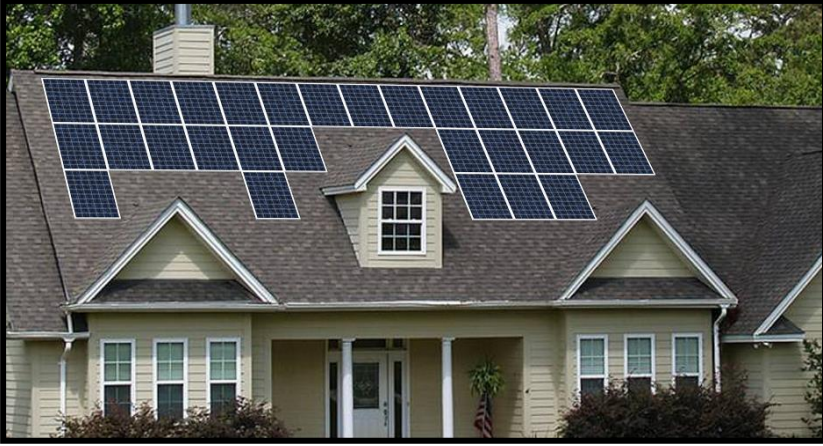
Şekil 9. Çatıya yerleşimi yapılan fotovoltaik paneller
