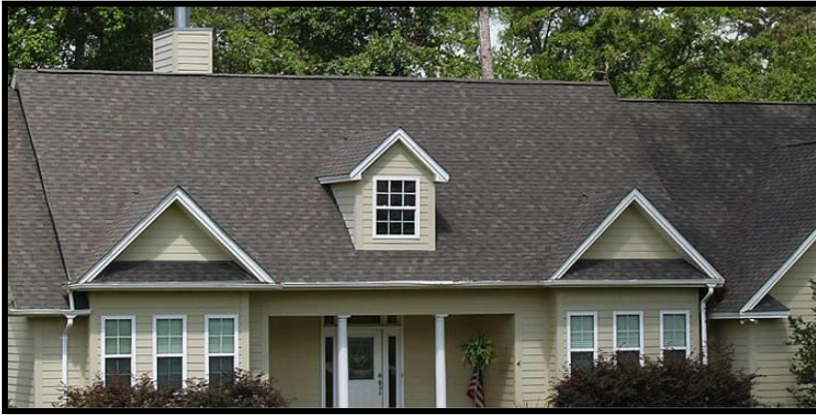
Şekil 7. Santralin kurulumunun yapılacağı evin çatısı
