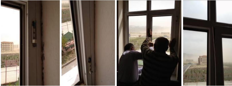
Şekil 10: Menteşesi kırılan ve yerinden sökülen pencere kanadı (18.04.2012)
