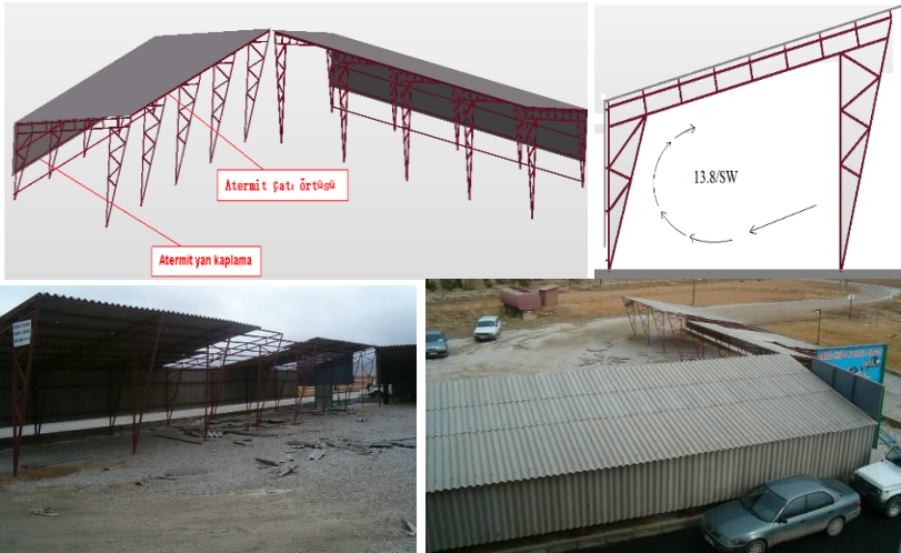
Şekil 8: Otoparkının çatı kaplamasında oluşan hasarlar (23.01.2005)
