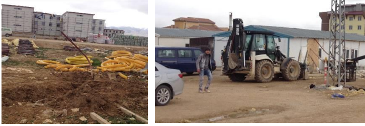
Şekil 17: Yıkılan çatıdan uçan parçalar (28.03.2015)
