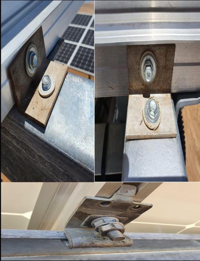
Şekil 6: Çelik konstrüksiyonda paslanma
