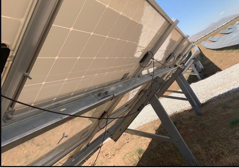
Şekil 10: Panel kabloların sarkma
