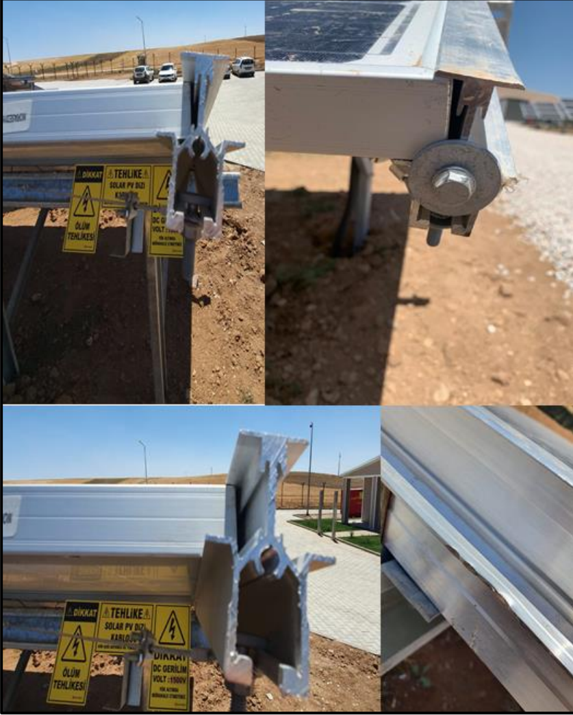
Şekil 7: Çelik konstrüksiyon alüminyum kirişlerde sorun
