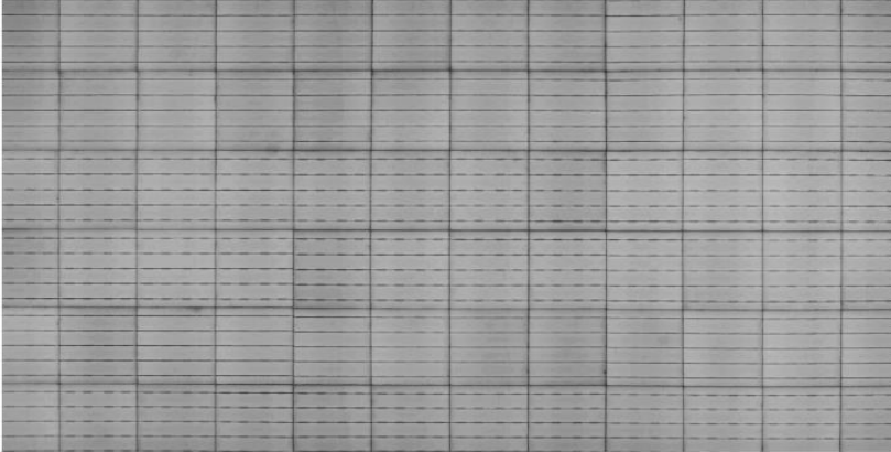
Şekil 14. Elektrolüminesans (EL) Test Sonucu [15]
