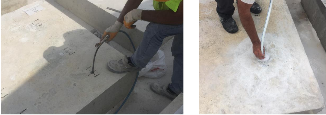
Şekil 7. Açılan Deliklerin Hava ve Su ile Temizlenmesi
