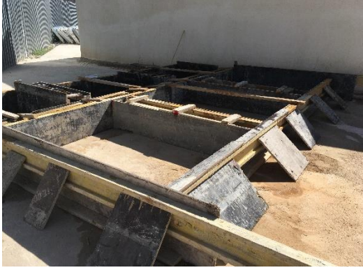
Şekil 3. C10 ve C30 Beton Kalıplarının Hazırlanması
