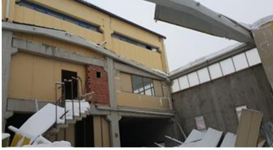
Şekil 1. KONSAN sanayi sitesinde bulunan sanayi yapısının kar yağışı sonrası göçmüş haldeki görünümü
