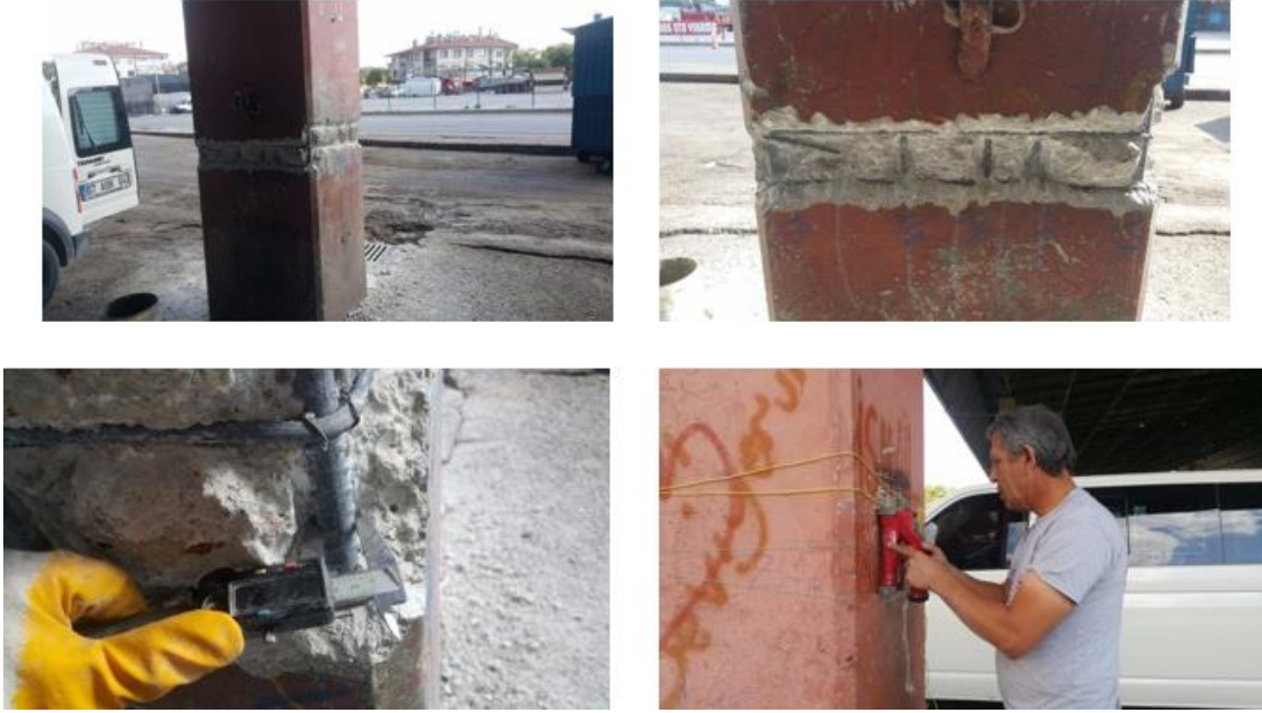
Şekil5. Taşıyıcı betonarme kolonlarda gerçekleştirilen donatı tespit çalışması
