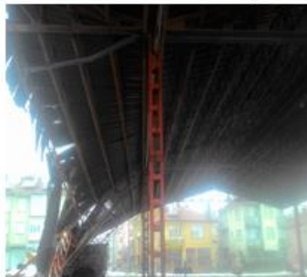
Şekil 2. Karaman Kültür Merkezi İnşaatı ve Akşehir Pazar yerinin çöken çatıları
