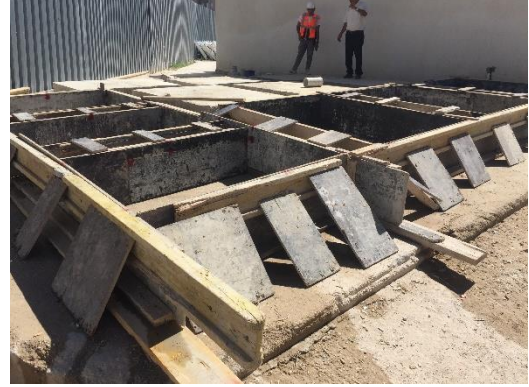
Şekil 3. C10 ve C30 Beton Kalıplarının Hazırlanması
