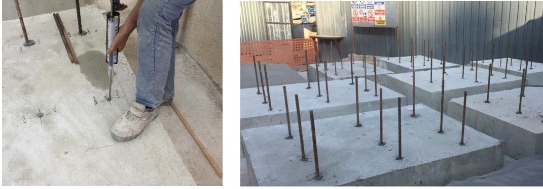
Şekil 8. Açılan Deliklere Donatı Ekilmesi
