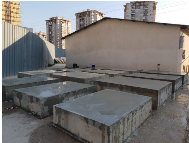
Şekil 5. Betonların Sulanması
