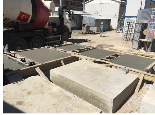
Şekil 4. C10 ve C30 Beton Dökümü
