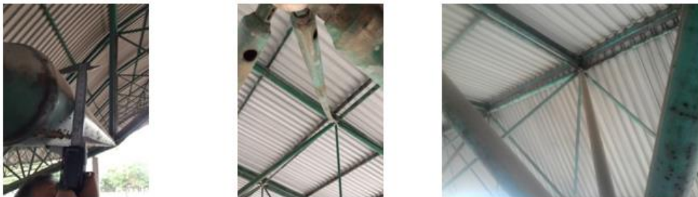
Şekil 8. Taşıyıcı boru kesitli elemanlarda yapılan kesit ölçümleri ve oluşan hasarlar
