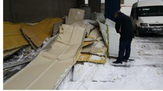
Şekil 1. KONSAN sanayi sitesinde bulunan sanayi yapısının kar yağışı sonrası göçmüş haldeki görünümü
