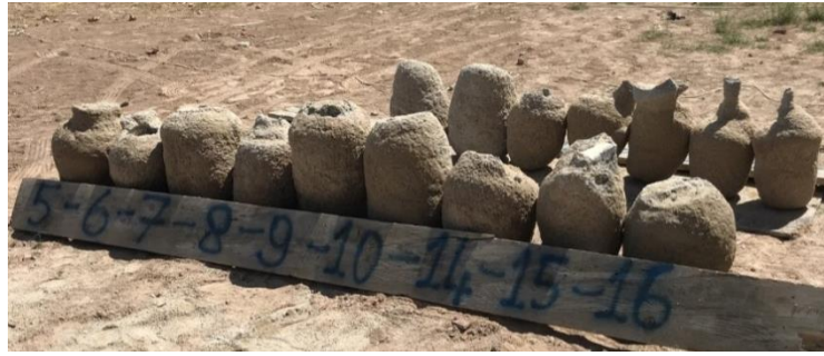
Şekil 3. Jet grout kolonlarının görünümü.
