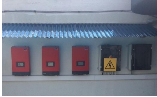
Şekil 4: DÜBİT çatısındaki fotovoltaik paneller için kullanılan üç evirici cihazı (kırmızı olanlar) ve kontrol cihazları (siyah olanlar).
