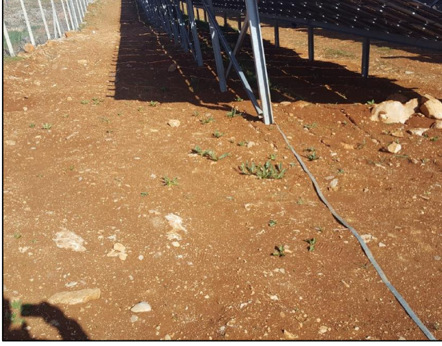
Şekil 15. Topraklama Hataları-1
