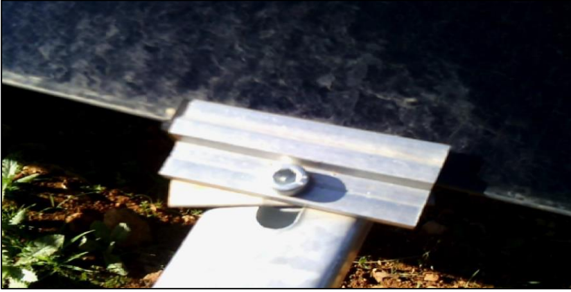
Şekil 27. Panel Tutucu Hataları-4
