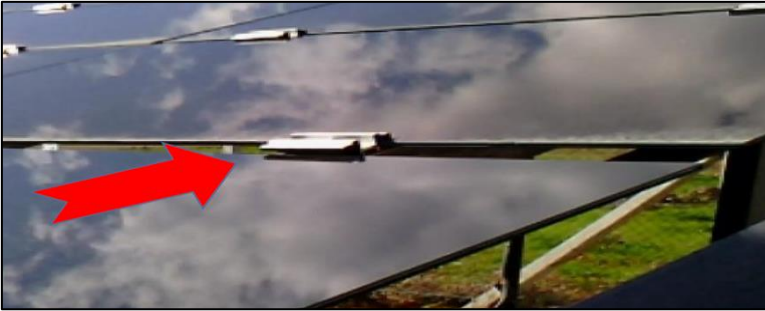
Şekil 26. Panel Tutucu Hataları-3
